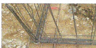
Nœud de chaînage - Continuité mécanique
