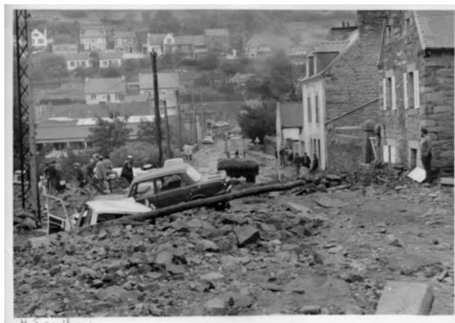
Les dégâts au bas de la Vieille Côte de Gouët (Photo : Archives municipales de Saint-Brieuc)
