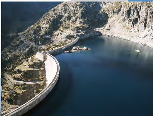
Barrage Cap de Long (source : EDF)
