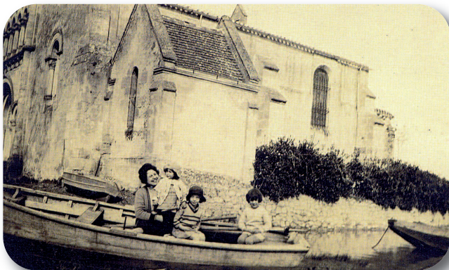
La crue de 1930 est la crue de référence. L'eau est montée jusqu'à l'église...
