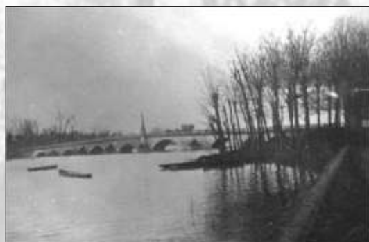
Crue de 1927 : 3,80 m
