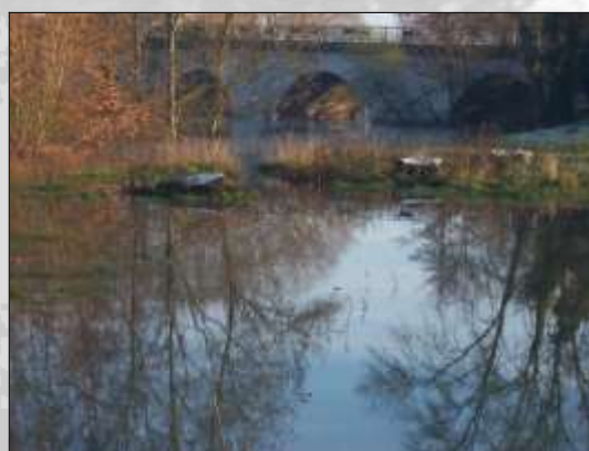
Crue de 2003 : 3,75 m
