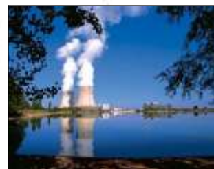
Centrale de Saint-Laurent-des-Eaux
