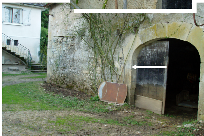
La Mouline en rive droite Repère de la crue du 20/10/1872 Hauteur du repère à 1.04 du sol
