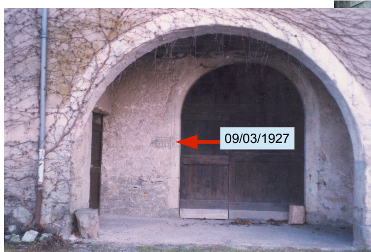
1- Maison en bordure RD8
