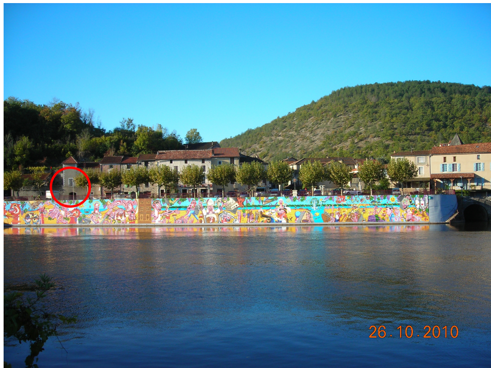
1 – Maison en bordure RD8
