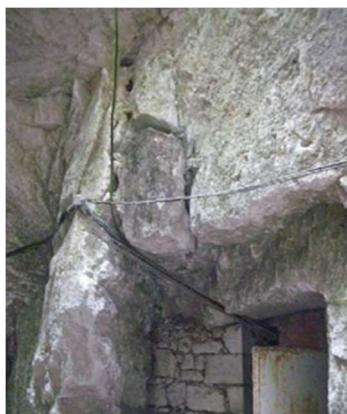
Illustration 1: Création d'un effondrement dû à la présence d'une cavité souterraine (modifié d'après MEED)
