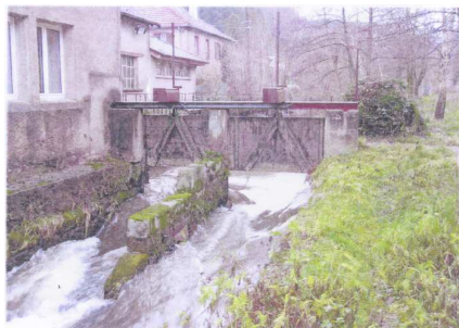
Barrage sur le bras usinier permettant de remonter la ligne d'eau à l'étiage
