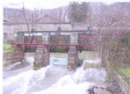
Ouvrage latéral de décharge restituant les eaux de crues, dans le lit naturel de la Zorn
