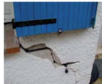
Des phénomènes de fissuration des murs
