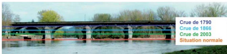
Niveaux mesurés sur l'échelle de crue du pont
