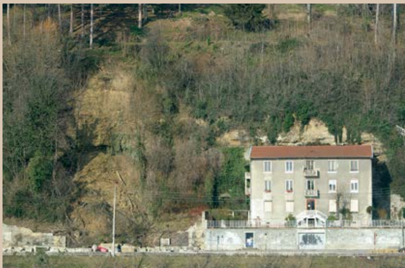
Eboulement du mur d'une copropriété et d'une partie de la Balme provoqué par de fortes pluies - février 2009
