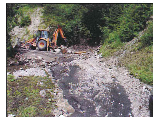
Route de la Buchille endommagée et coupée à la suite d'une coulée de boue
