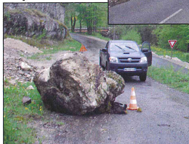
..... Chute de pierres sur la route de la Buchille (Pont des Doubines, 2010) .....
