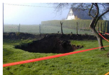
Mouvement de terrain (cavités souterraines)
