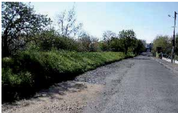
Digue de protection au niveau du stade
