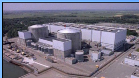
La centrale de Fessenheim (68)
