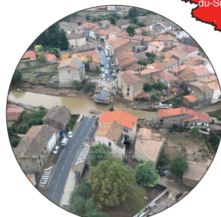
Vue de Villegailhenc, source Cdt Biscay et Barthez. Aude / octobre 2018 : 220 M€ de dégâts, 15 décédés.
