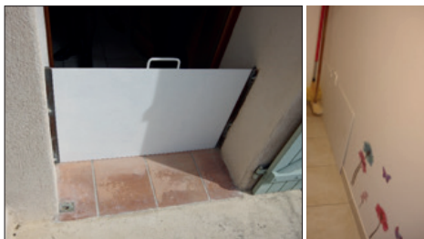
Pose de batardeaux, source Cyprès
