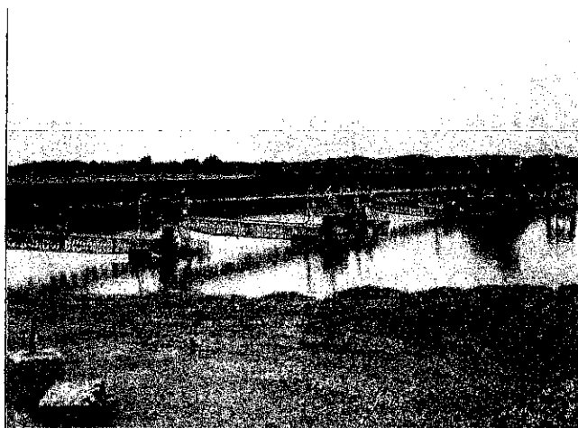
Drague à godets et convoyeur mobile secondaire flottant
