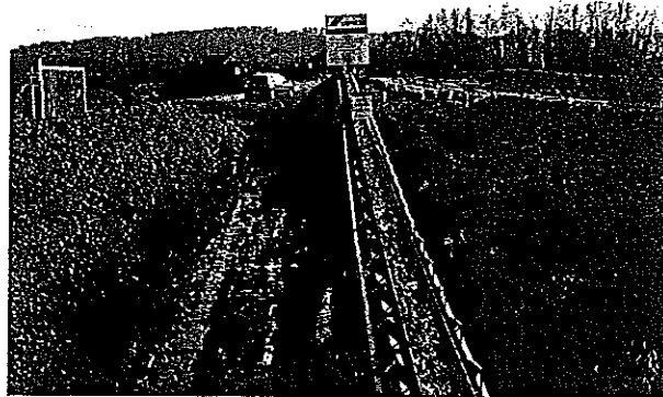
Sortie des matériaux vers l'installation de LABATUT sur les bandes transporteuses.
