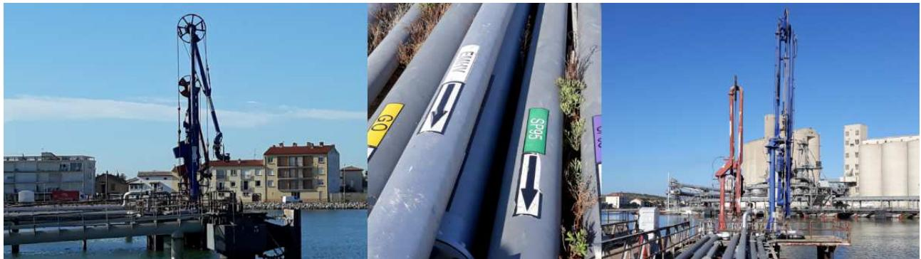
Le poste de déchargement D2 est constitué d'une plateforme et passerelle avec caillebotis posées sur des pieux battus.
