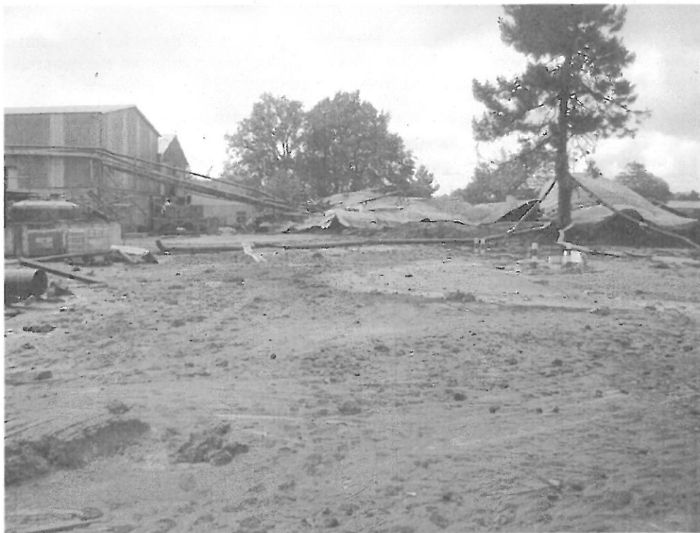
Photo 1 : Vue de la cuve du coté où la vague de liqueur noire s'est propagée
