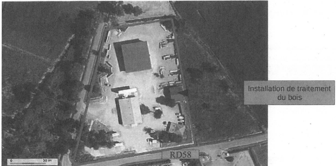
Photo 1: Vue aérienne du site
