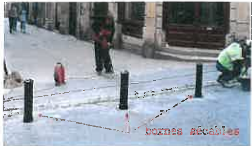
Bornes sécables par un homme sur poussée
