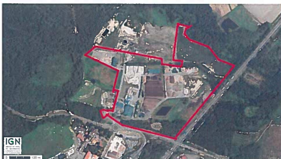
Vue aérienne site autorisé
