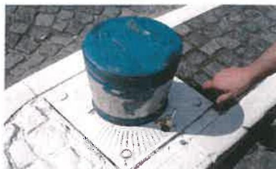
Borne escamotable et triangle de 15 mm
