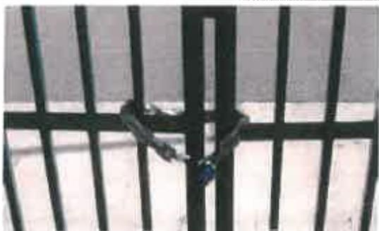
Chaîne ou cadenas de 12 mm maximum, sécable au coupe bouton
