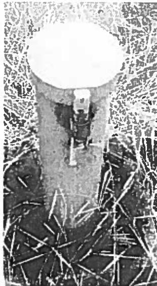
**ECART3 :** *Le forage et le piézomètre ne sont pas cadenassés ou correctement cadenassés comme précisé au point 2.4 de l'article 2 du titre 1 de l'arrêté préfectoral du 25 janvier 2011.*
