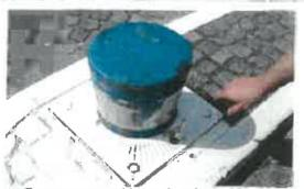
Borne escamotable et triangle de 15 mm
