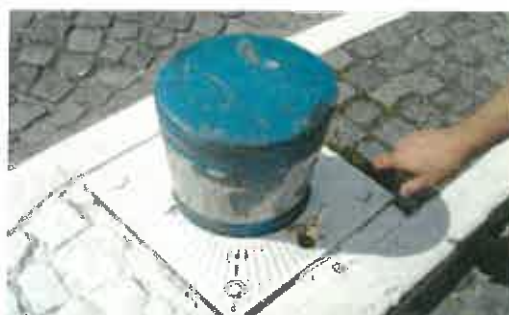
Borne escamotable et triangle de 15 mm
