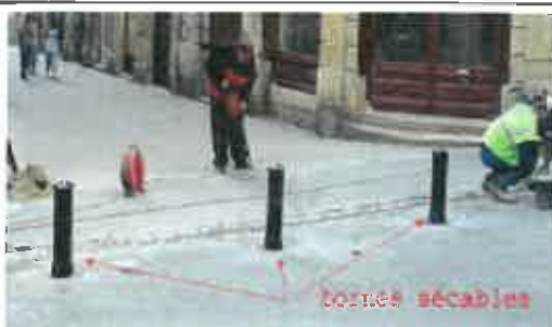
Bornes sécables par un homme sur poussée
