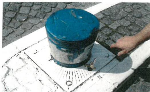
Borne escamotable et triangle de 15 mm
