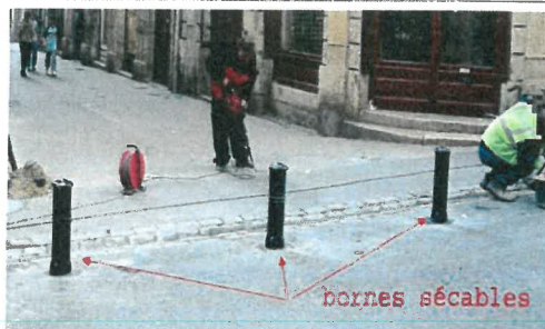
Bornes sécables par un homme sur poussée
