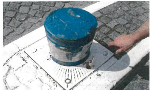
Borne escamotable et triangle de 15 mm
