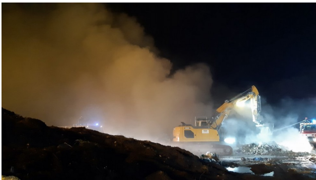
Photo 5: Etalement et refroidissement des déchets broyés (23h30)
