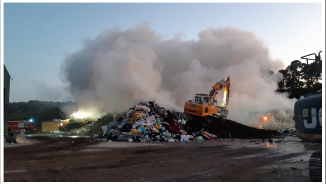
Photo 2: incendie en cours, avec mise en place d'une couverture de terre sur les déchets non broyés (22h)
