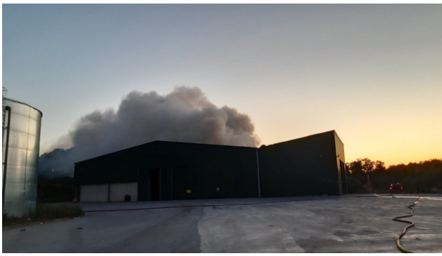
Photo 1: panache de fumée, à l'extérieur du bâtiment de mise en balle des déchets
