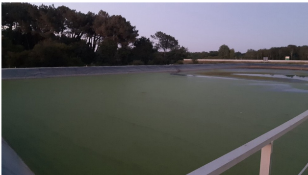
Photo 3: bassin de collecte des eaux pluviales et des eaux incendie
