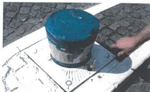
Borne escamotable et triangle de 15 mm
