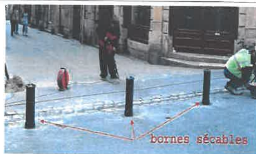
Bornes sécables par un homme sur poussée
