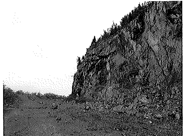
Piège à cailloux à l'altitude 672 NGF, d'une largeur de l'ordre de 20 mètres
