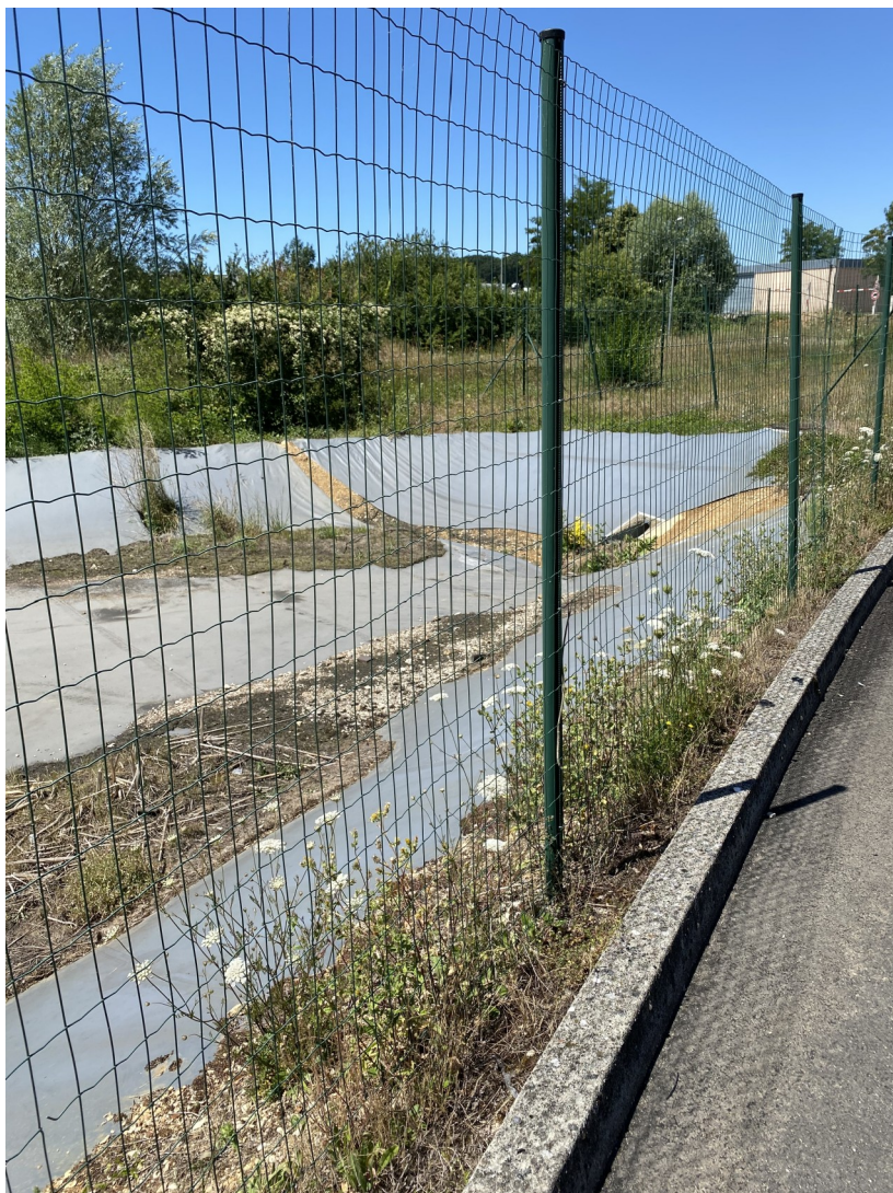
Figure 1 : Bassin de rétention des eaux accidentellement polluées
