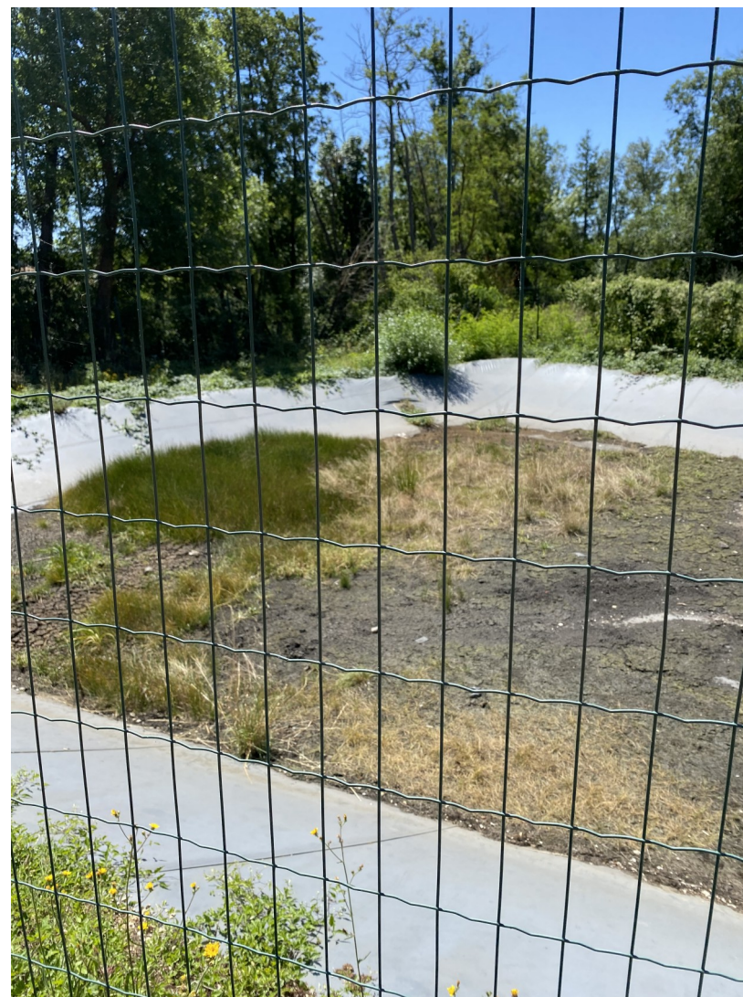
Figure 2 :Bassin de rétention des eaux accidentellement polluées
