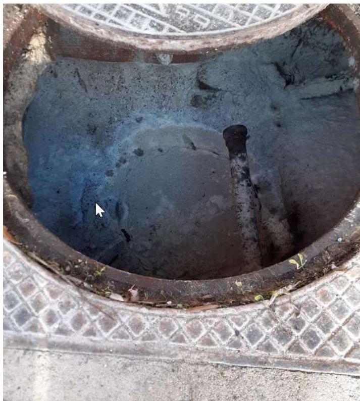
Ancienne cuve d'hydrocarbures inertée
