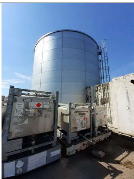
Stockage d'acétone et essence C en extérieur sans auvent ni récupération des égouttures
