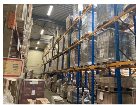
Non-respect de l'espace minimal de stockage entre la partie haute du stockage et la base de la toiture
