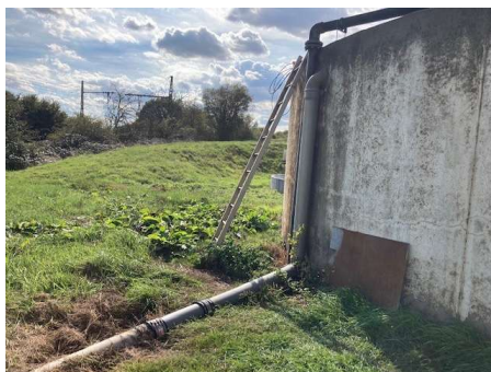
Canalisation de transfert d'effluent
