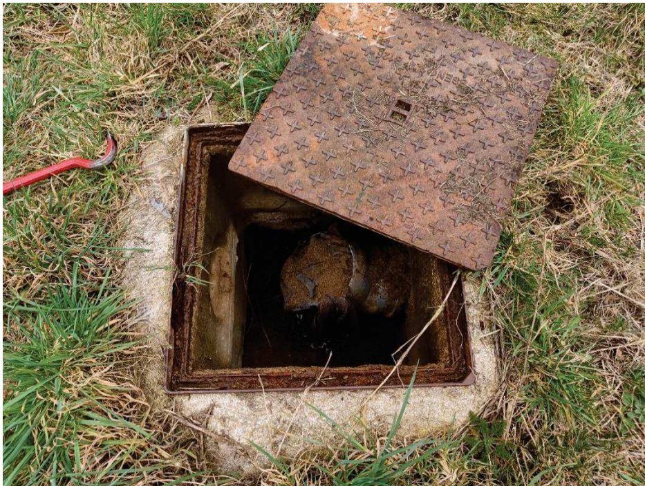
Figure 4 : Premier regard du séparateur hydrocarbures
