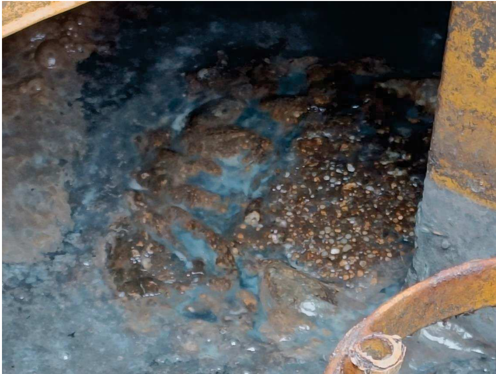
Figure 7 : Gros plan des matières en surface dans le séparateur hydrocarbures
