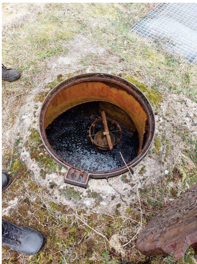
Figure 6 : Second regard du séparateur hydrocarbures
