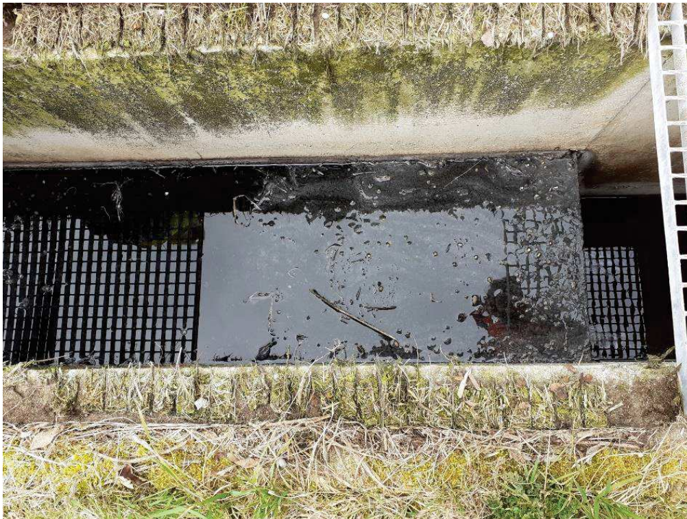
Figure 8 : Aspect de l'eau qui rejoint le milieu naturel en sortie de séparateur hydrocarbures
