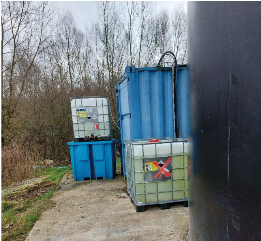
Figure 19 : Second container de 1 000 L qui n'est sur rétention
