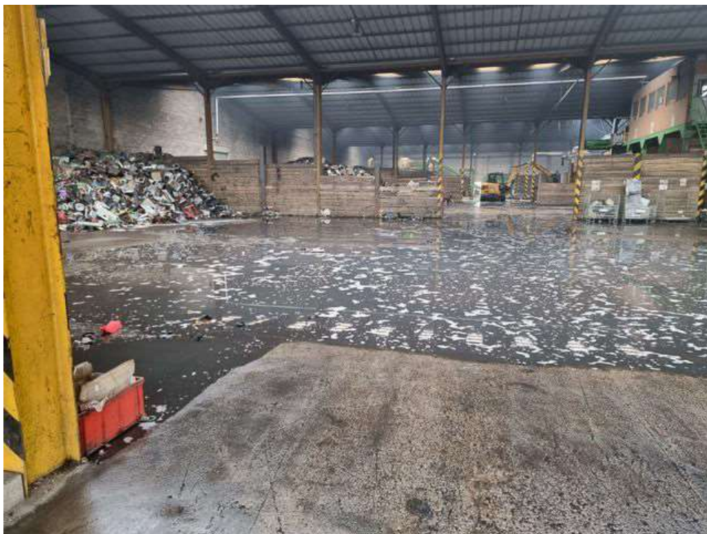
Photos 4 rétention interne avec eaux d'extinction avant pompage
