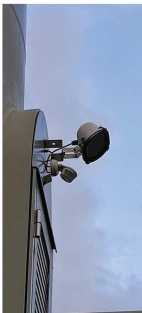
Éclairage avec détecteur de présence
