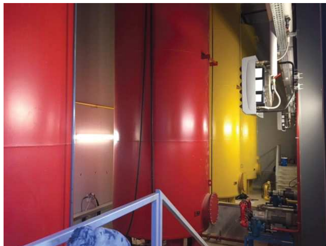
Photo 2 – cuves de polyol et d'isocyanate
