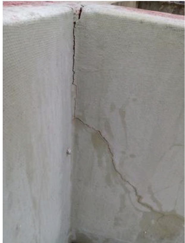
Angle et fissuration cuvette stock de soude.
