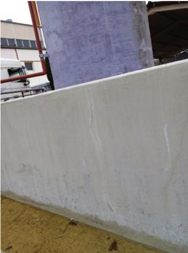
Fissuration paroi cuvette de rétention stock de soude.
