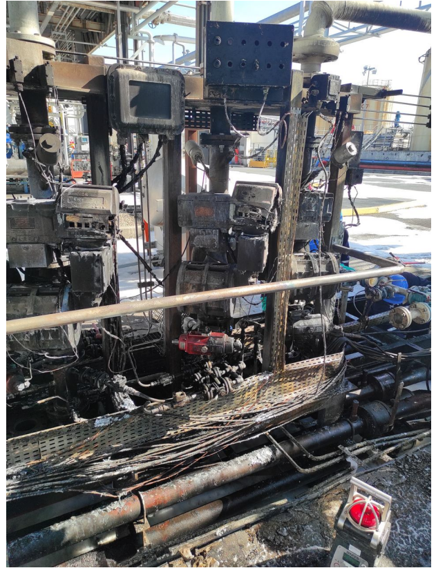
Illustration 12: Dégâts visibles sur le poste 7
