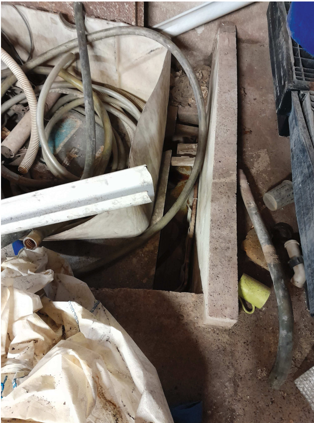
Fosse de récupération des eaux de lavage à l'intérieur du bâtiment
