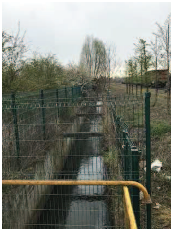
Confinement des eaux d'extinction incendie
