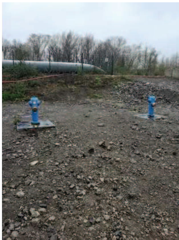
Poteaux d'aspiration associés à la réserve d'eau d'extinction incendie
