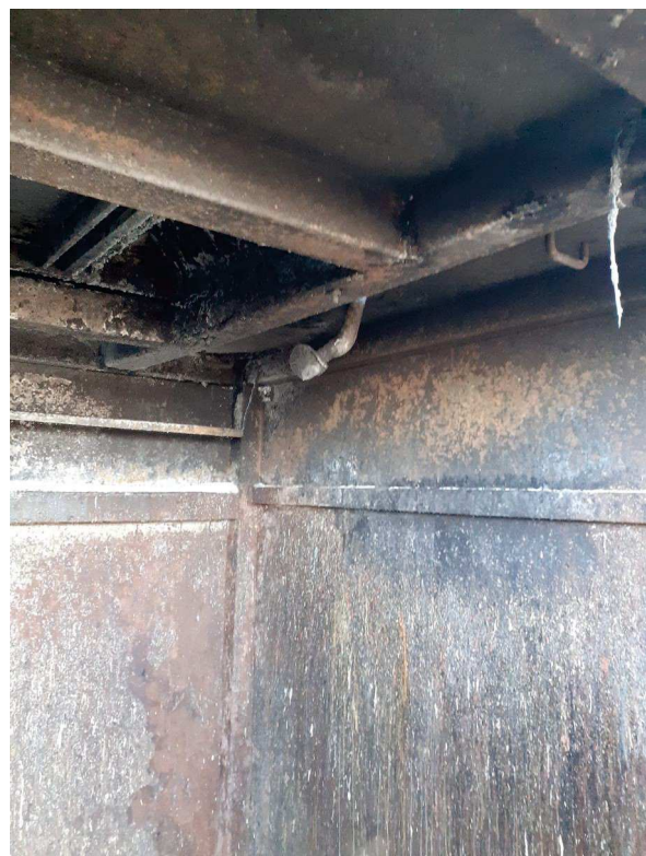
4 et 4 bis – détecteur incendie à gauche – buse d'extinction à droite.
