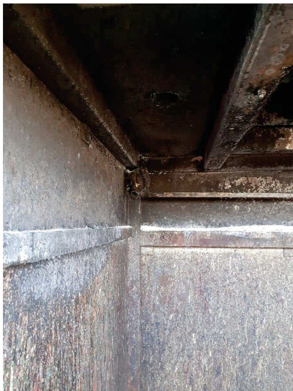
4 et 4 bis – détecteur incendie à gauche – buse d'extinction à droite.
