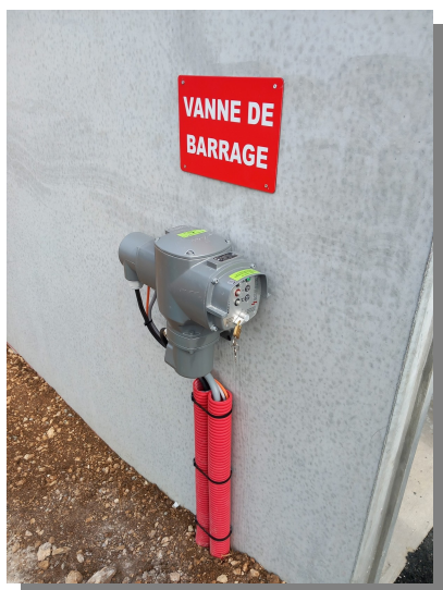
Vanne de confinement pilotée
