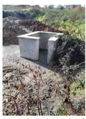
Le piézomètre amont, situé sur la plateforme nord (le site est constitué de 2 plateformes contiguës), est protégé par un mur bétonné afin d'éviter tout choc lors du déchargement des boues. Cependant, lors de la visite, l'inspection a constaté que celui-ci était recouvert de boues et donc pas accessible pour la réalisation du suivi semestrielle des eaux. L'exploitant s'est engagé à
