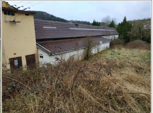
Ancien bassin de décantation au fond et local du transformateur électrique à gauche
