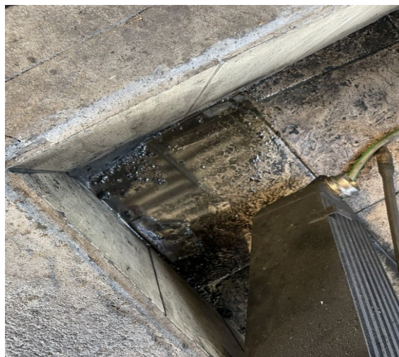
Bac de rétention maçonné refermé.
